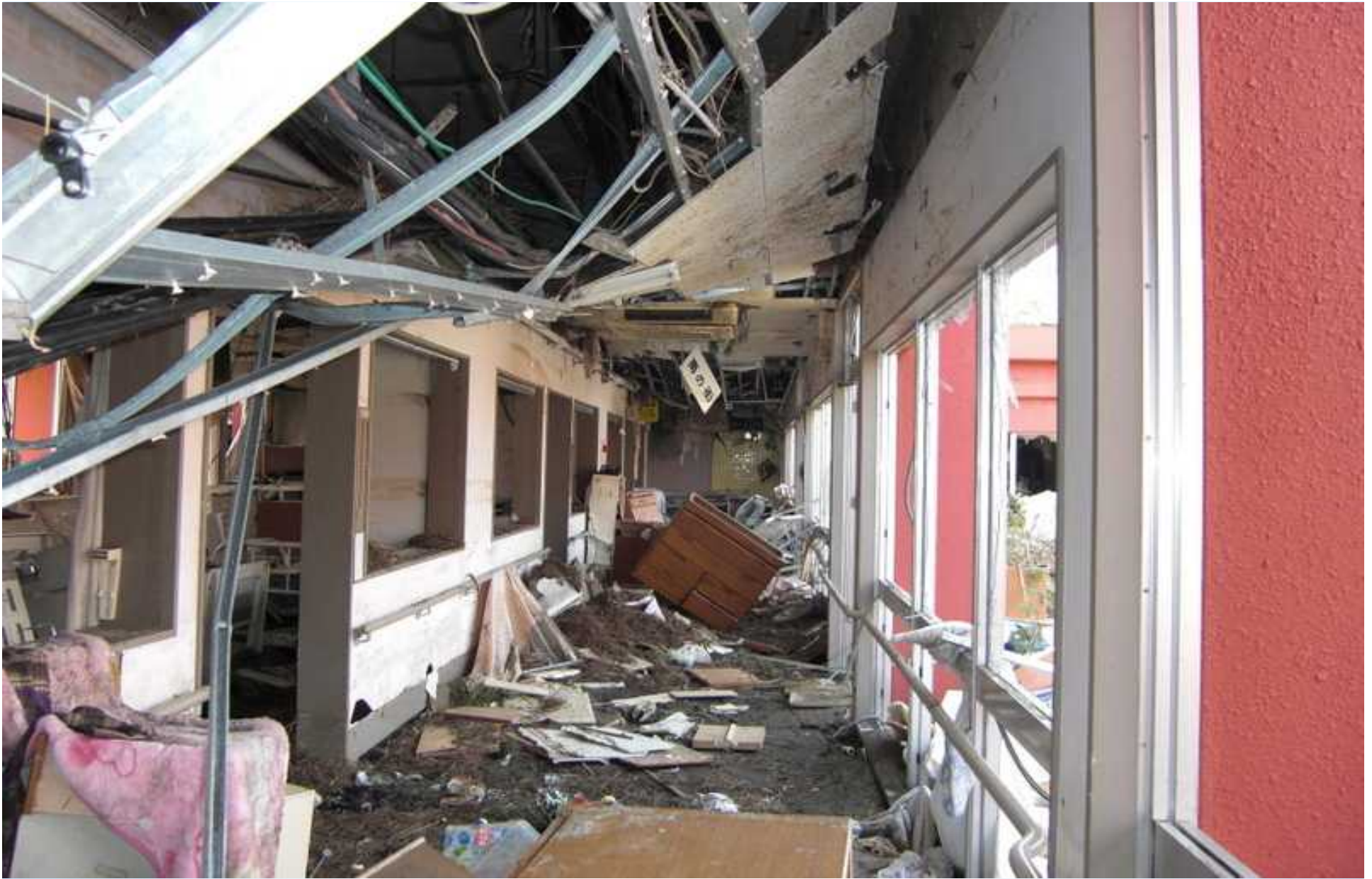
居室南側の廊下
