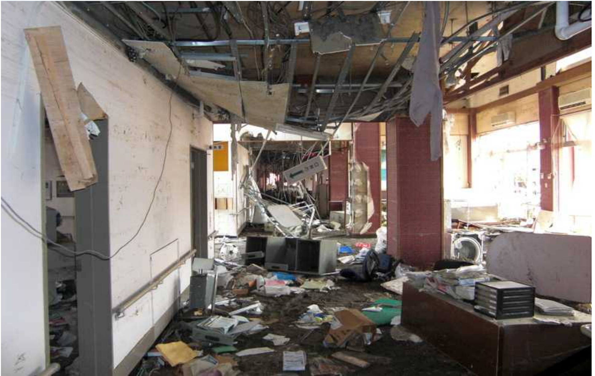
事務室前の様子
