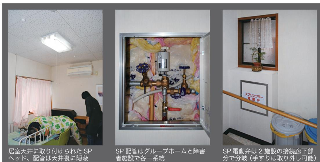
居室天井に取り付けられた SP ヘッド、配管は天井裏に隠蔽
