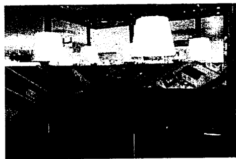
各テーブルの上部には、間接照明を兼ねた集煙用のシェードを設置。
