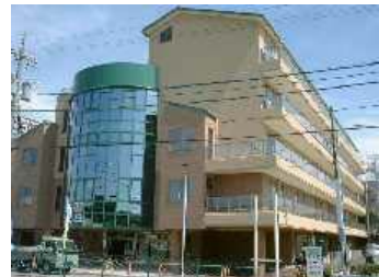
特別養護老人ホーム エレガントなぎの浦 ケアハウス アンジェリーなぎの浦
